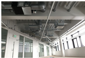
高効率空調の整備
