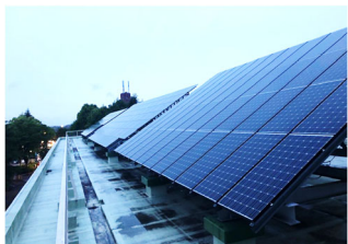
創エネルギー設備の整備
