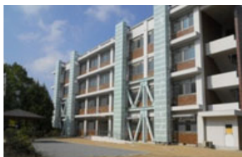
老朽改善された施設
