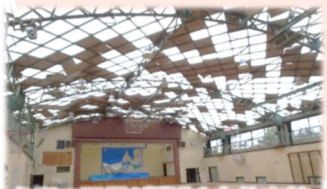
台風で屋根が消失した体育館
